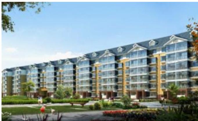
地上六层为住宅楼，住宅楼部分地下一层为设备夹层，地下二层为非燃品库房和人防。3#、4#住宅楼之间与 4#、5#住宅楼之间为地下为车库。建筑外墙外保温面层主要为面砖，首层棕红色面砖、1-5 层桔红色面砖、6 层为白色涂料搭配，文体活动站外墙为石材幕墙和玻璃幕墙，成型线条丰富。本工程具有做为住宅且使用功能的多样性特点和专业化工艺标准要求高的特点。设备设施完善，有弱电系统，包括有线电视、宽带入户、可视电话系统、门禁系统、楼宇自控制系统等。设计的专业种类多，有外幕墙及门窗工程、消防系统工程、设备、煤气系统工程、高低压配电室工程、锅炉房工程、一户一表工程、门禁系统、电梯工程等。
