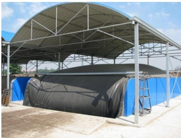
工艺流程：根据预定的 C/N 比和水分，用装载机将各种物料按比例分层堆入建造在温室内的发酵槽，用置于发酵槽上的翻搅机翻动物料，进行好氧预发酵，利用生物能和太阳能使物料升温。待物料升温到 70℃左右，将制备好的厌氧菌种混入，再用翻搅机搅拌均匀，然后移出翻搅机。在发酵槽上覆盖柔性膜，将软管嵌入发酵槽壁的沟槽内并充气压住柔性膜，使发酵槽密封，物料在中温（35℃左右）条件下厌氧发酵生产沼气。喷淋装置将带有厌氧菌的温水喷入，促进厌氧发酵，经过物料的沥出液进入集水罐重复使用。发酵槽和集水罐中产生的沼气用气泵输送到储气罐。厌氧产气期结束，将槽内沼气抽空，收起密封膜，翻搅机进一步翻动物料脱水制肥。本项目拟设置 8 个发酵槽，一般情况下有 4 个槽处于厌氧产气期，1 个槽处于好氧升温期，3 个槽处于脱水制肥期。
