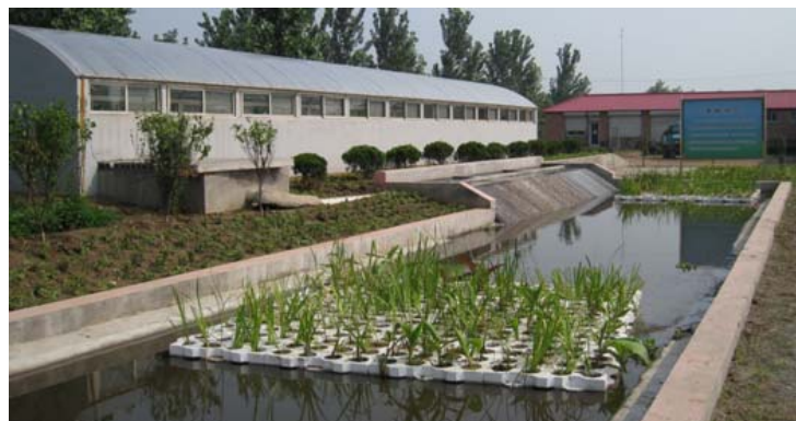
河南洛阳污水净化工程项目示范点
