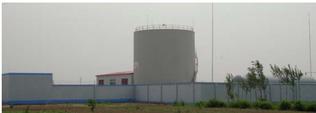
天津静海四党口秸秆沼气工程
